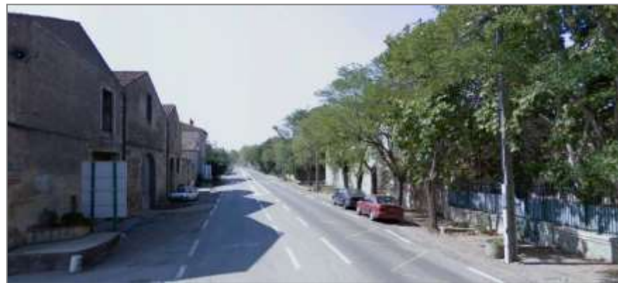
Les alignements d'arbres le long de la traversée
