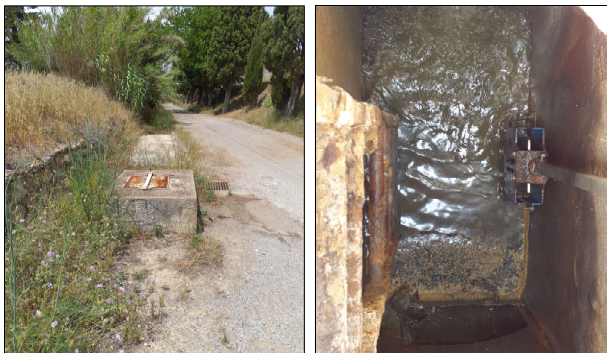
Figure 6 : Photographies du déversoir d'orage localisé en amont de la STEP
